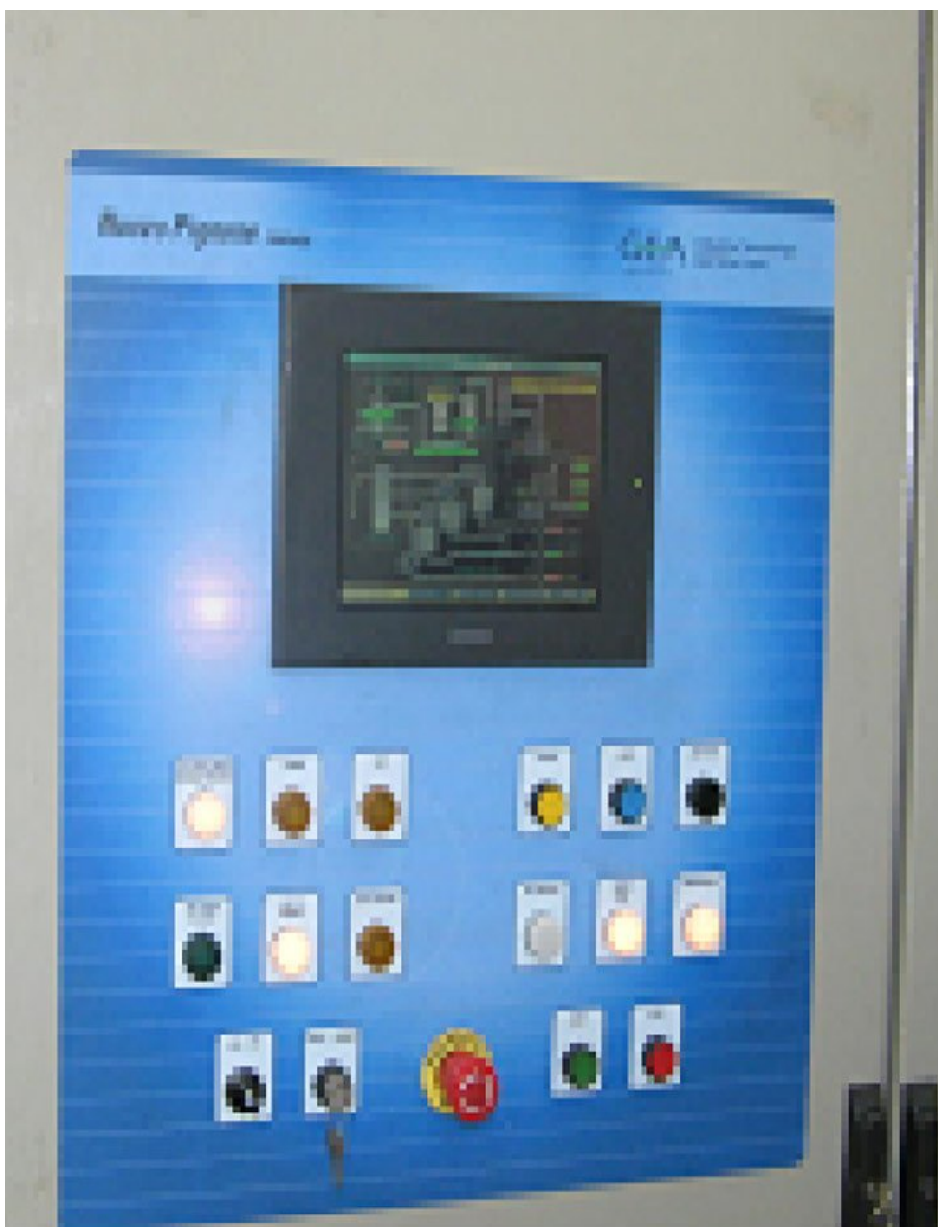
۴- تابلو کنترل درایر : تابلو کنترل درایر شامل کلید اصلی ، کلیدهای کنترل کولر و فن ، کنترلر زمینس ، منبع تغذیه ، پیل عمل کننده ، چراغهای سیگنال و شاسی اضطراری می باشد .
